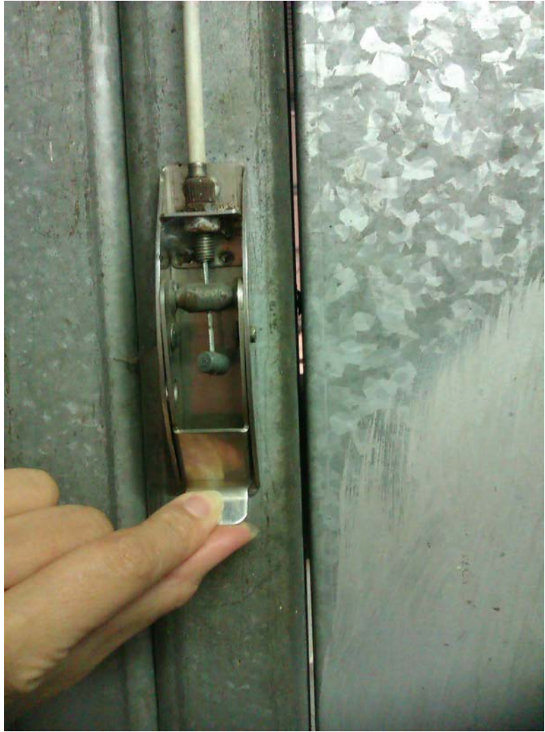
3.手動離合器開關(推拉式)停電時往手動定位(示範定位)
