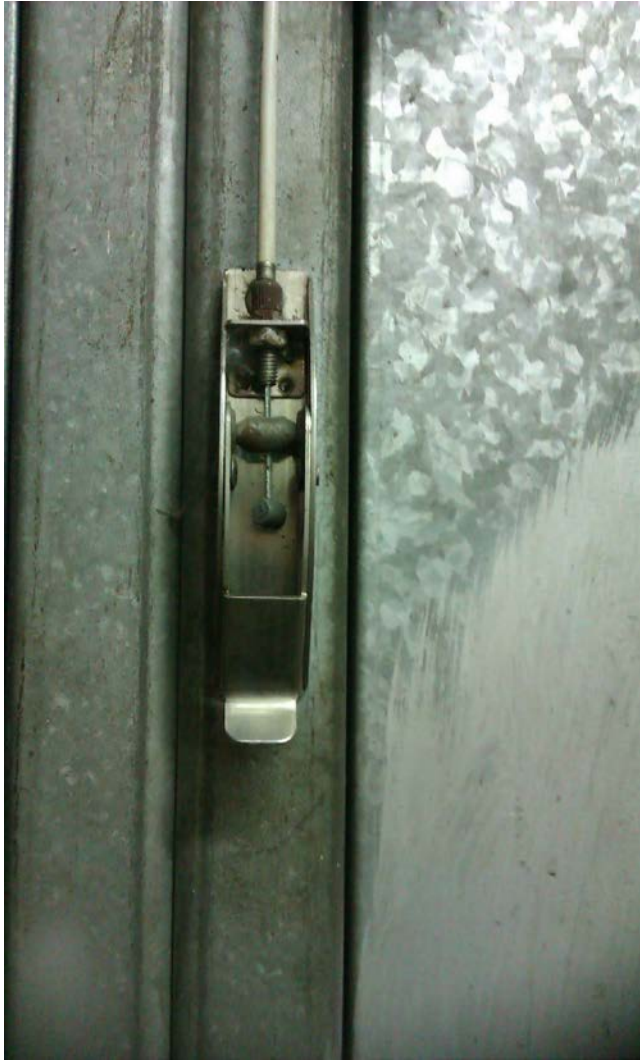
1.手動離合器開關(推拉式)正常定位
