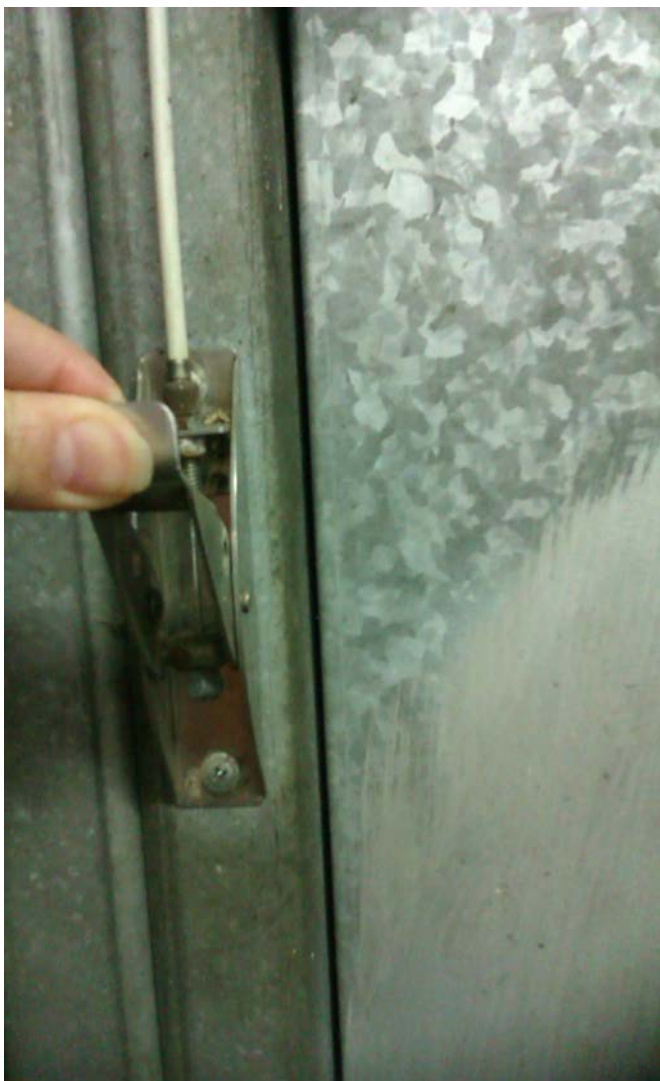
2.手動離合器開關(推拉式)停電時往手動定位(示範往上)
