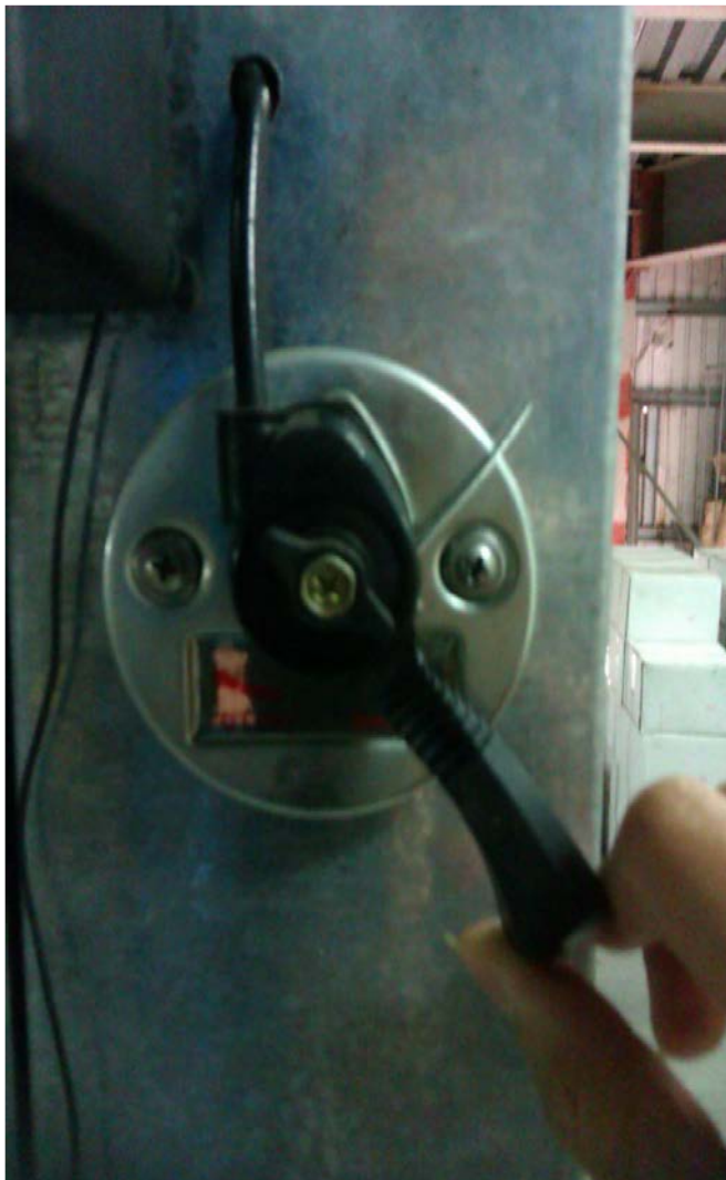
2.手動離合器開關(旋扭式)停電時往左手動定位（示範往左）
