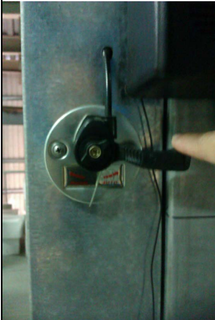
3.手動離合器開關(旋扭式)停電時往左手動定位（示範往左定位）
