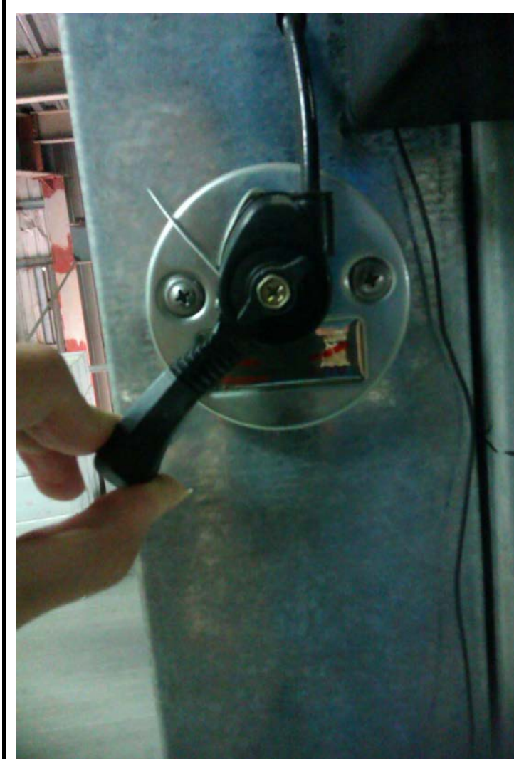
3.手動離合器開關(旋扭式)停電時往左手動定位（示範往左定位）
